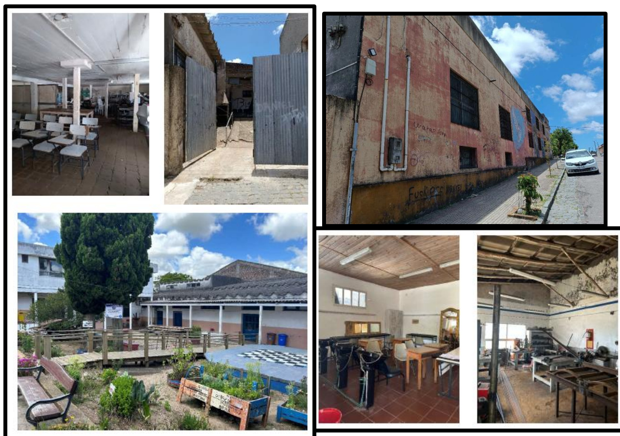
Figura 53 – Relevamiento fotográfico Liceo. Fuente: Informe ANEP, 2025
