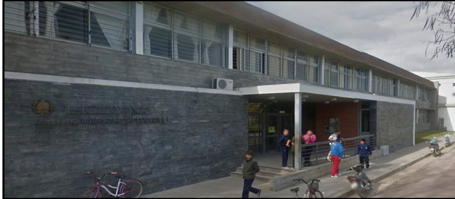
Figura 70 – Liceo Nº3 Mariana Saldain Pioli. Fuente: Google Street View, 2026.
