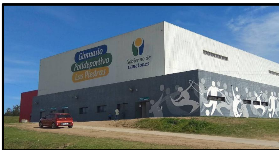
Figura 56 – Gimnasio Polideportivo Las Piedras. Fuente: Google Street View, 2026.
