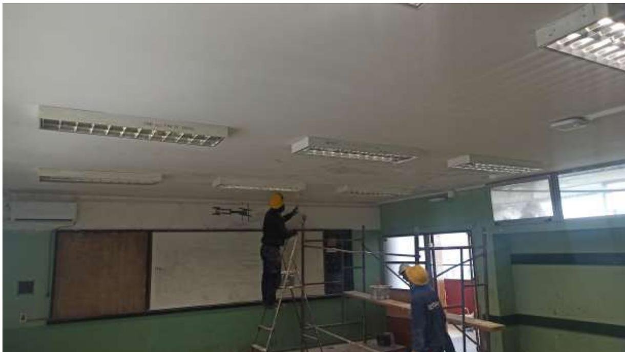
Reparación de revoques y pintura en aulas de planta alta que fueron afectadas por filtraciones de agua desde la azotea superior
